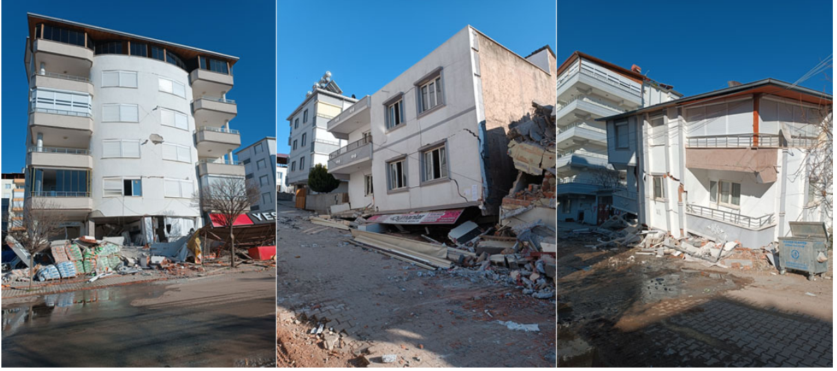
Şekil 5. Yumuşak kat hasarları
