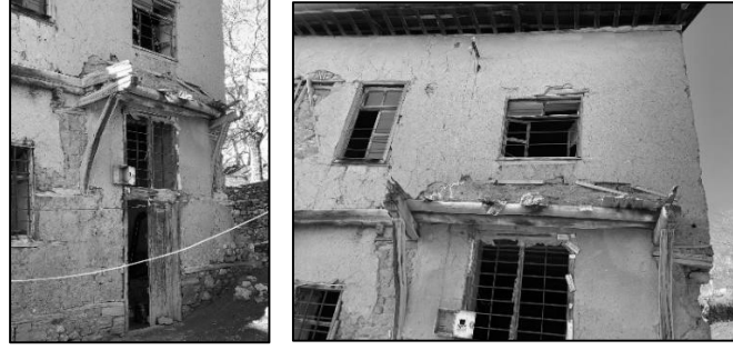
Şekil 8. Güneydoğu cephesinde yer alan cumba kalıntısı
