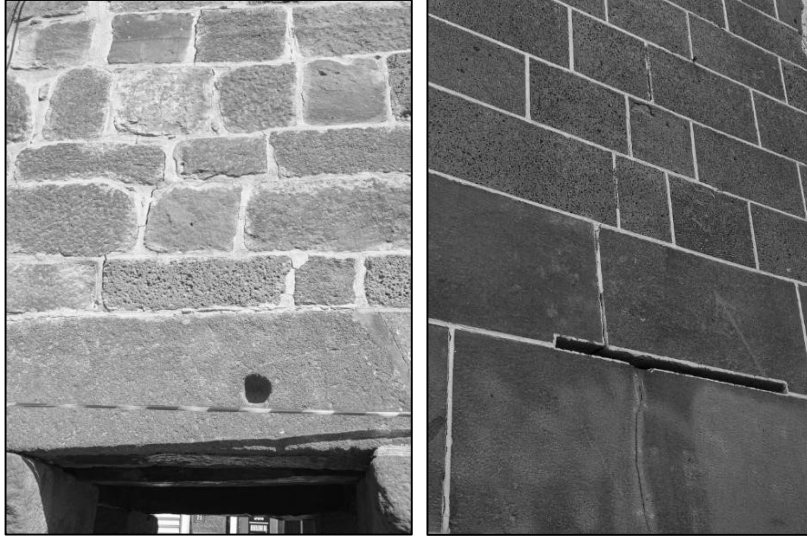
Şekil 10. Dört Ayaklı Minare gövdesinde tuğla, kalker, derz ve bazalt malzemedeki malzeme kaybı (2023)
